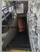
LAS ESCALERAS ESTÁN UBICADAS EN FRENTE DE LO INDICADO. LLEVAN AL SUBSUELO DONDE SE ENCUENTRAN LOS BAÑOS
