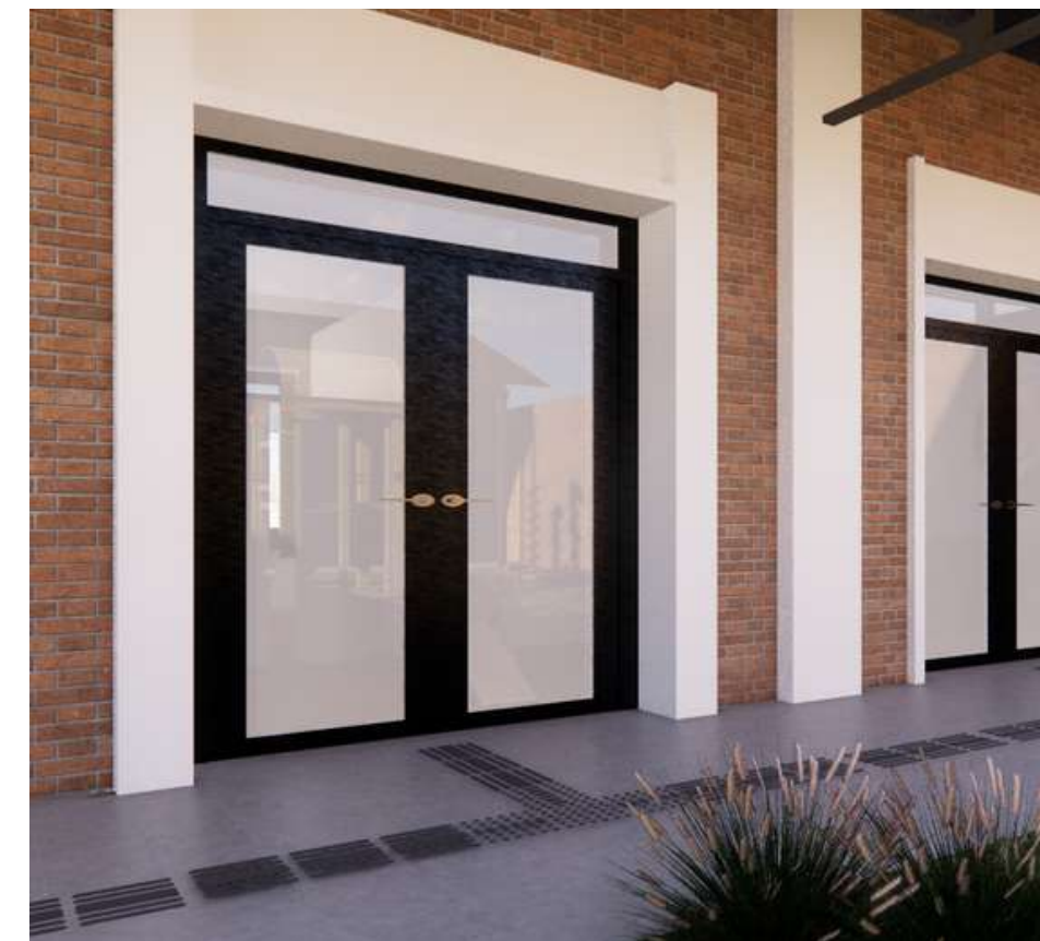
Baldosas podotáctiles en galerías
