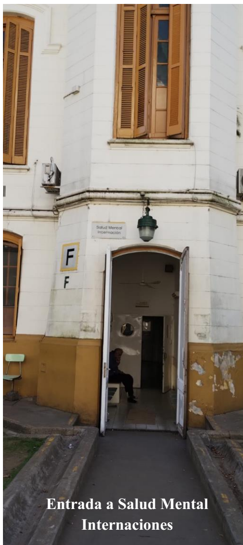
Imagen 24 Entrada a SM internaciones. Sala de espera, con bancos de madera
