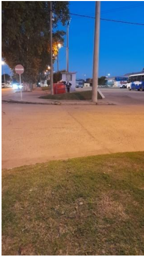
(Esq. de ingreso sin rampa)
