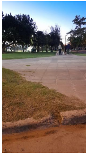
(Esq. de ingreso sin rampa)
